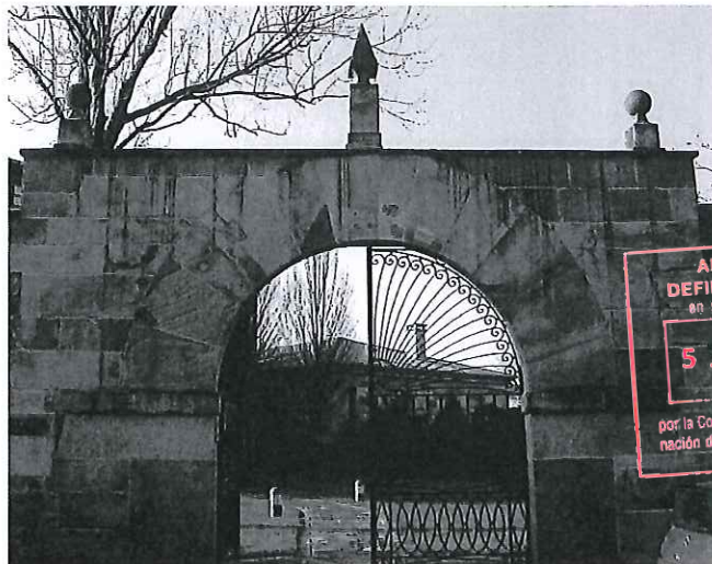
Estado actual de la portalada y la puerta original de la casa (1.762)
